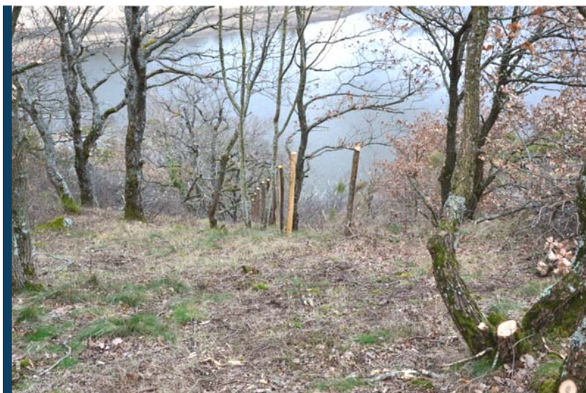
Photo 6: pose de piquets dans les pentes de la pointe de Chamousset
